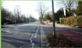
Rijksstraatweg in de gemeente Groningen –Vrijliggend fietspad (rood) –Scheiding weg en fietspad door struiken –Dubbele asmarkering –Haven voor bushalte
